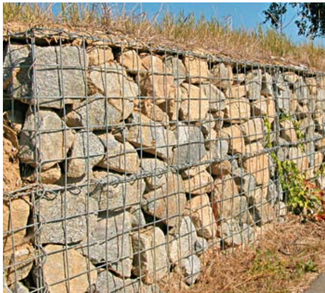
Robuste Lösung: Mit Drahtspiralen geschlossene Gabionen mit Granitschüttung und Bodenfüllung
