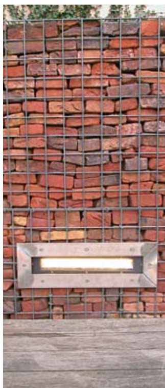
System Belgien: Mit Handform-Klinkern gefüllte Gabione in Antwerpen
