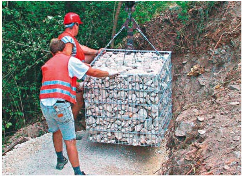
Kommt fertig auf die Baustelle: rawe-Steinkorb mit Kalksteinfüllung beim Versetzen auf Schotterfundament
